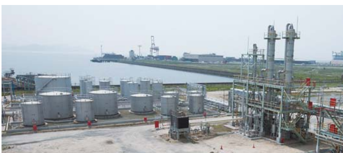
2007年7月稼働 精留設備
