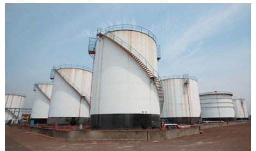
2004年4月稼働 輸入原料貯蔵タンク
