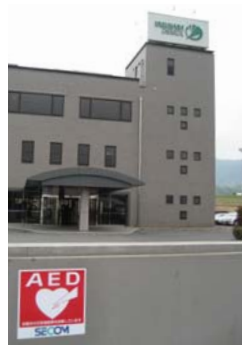
本社:AED設置を示すステッカー
